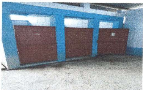
Foto 1: Mantenimiento a estructura (lijado, cambio de tubo, cepillado, sujeciones, aplicación de pintura) a puertas servicios sanitarios
