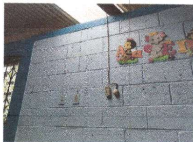
Foto 8: Instalación de unidades de fuerza
