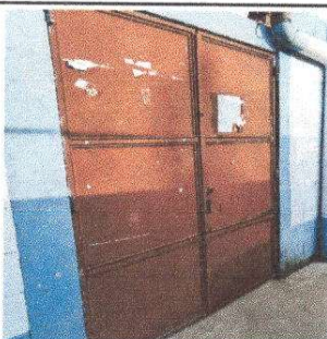
Foto 5: Sustitución de portón de Metal
