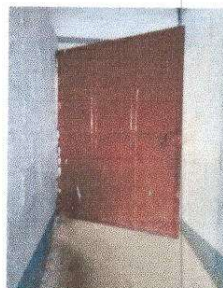
Foto 2: Sustitución de chapa
