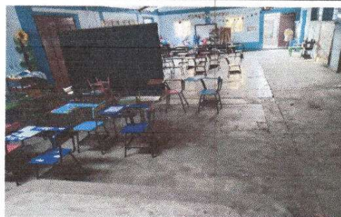
Foto 6: Sustitución de piso cerámico
