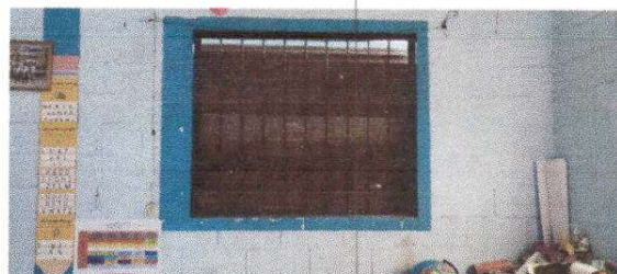
Foto 12: Fabricación e instalación de ventanas salón
