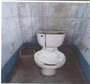
Foto 3: Sustitución de inodoro
