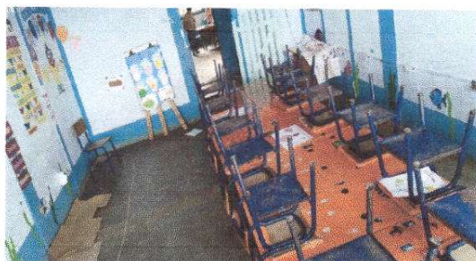
Foto 11: Sustitución piso cerámico aula 2
