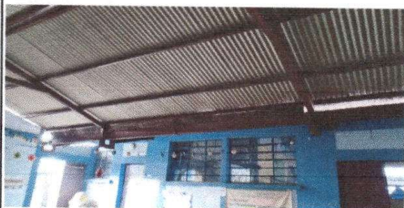
Foto 7: Sustitución canal de metal
